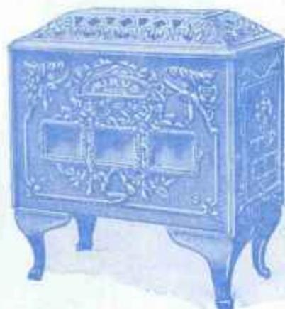
Cet appareil est constitué par une double carcasse en tôle d'acier, la carcasse intérieure faisant retour de flamme. La façade et les deux côtés sont revêtus de plaques de fonte d'un joli dessin art nouveau, et entièrement émaillés, ainsi que le dôme et les quatre pieds.
